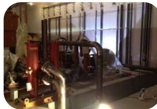
Травление, промывка и опрессовка трубопроводов систем смазки
