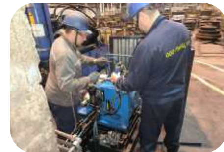
Монтаж и промывка трубопроводов
