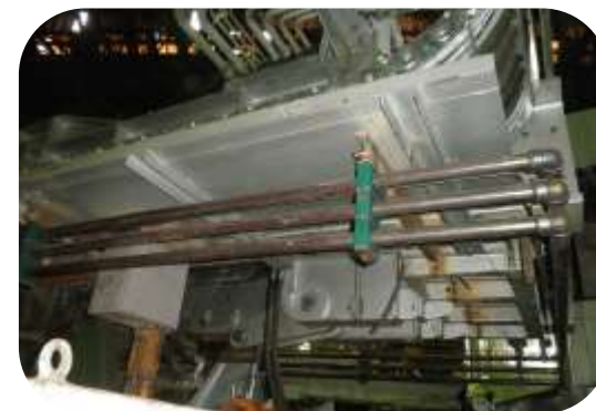
Монтаж, промывка трубопроводов
