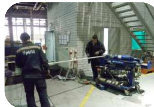
Трубная разводка и монтаж
