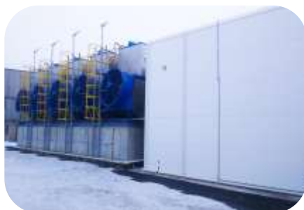
Проектирование, поставка, монтаж и пуско-наладка оборудования градирни испытательного центра
