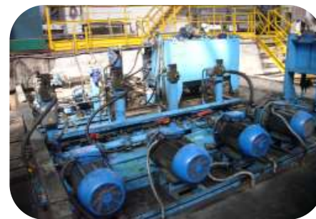
Трубная разводка и монтаж
