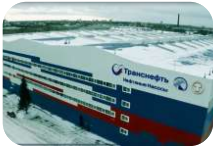
Испытательный центр АО «ТНН»
