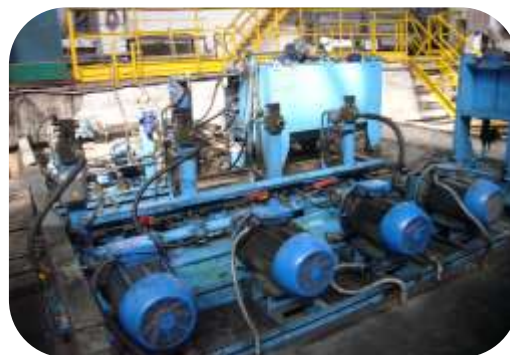
Трубная разводка и монтаж
