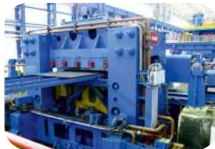
Капитальный ремонт листовых ножниц
