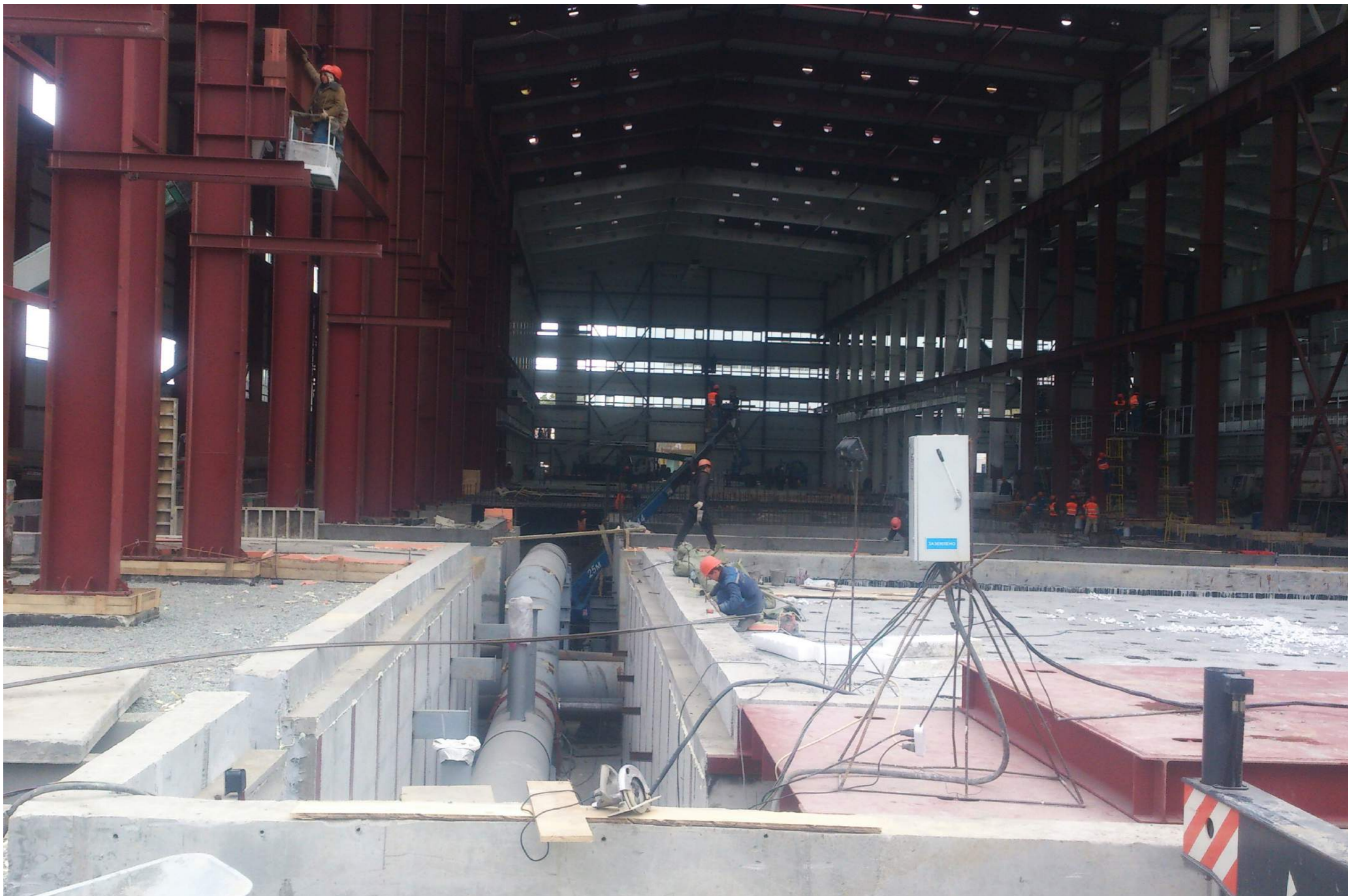
Монтаж трубопроводов для испытания горизонтальных насосов
