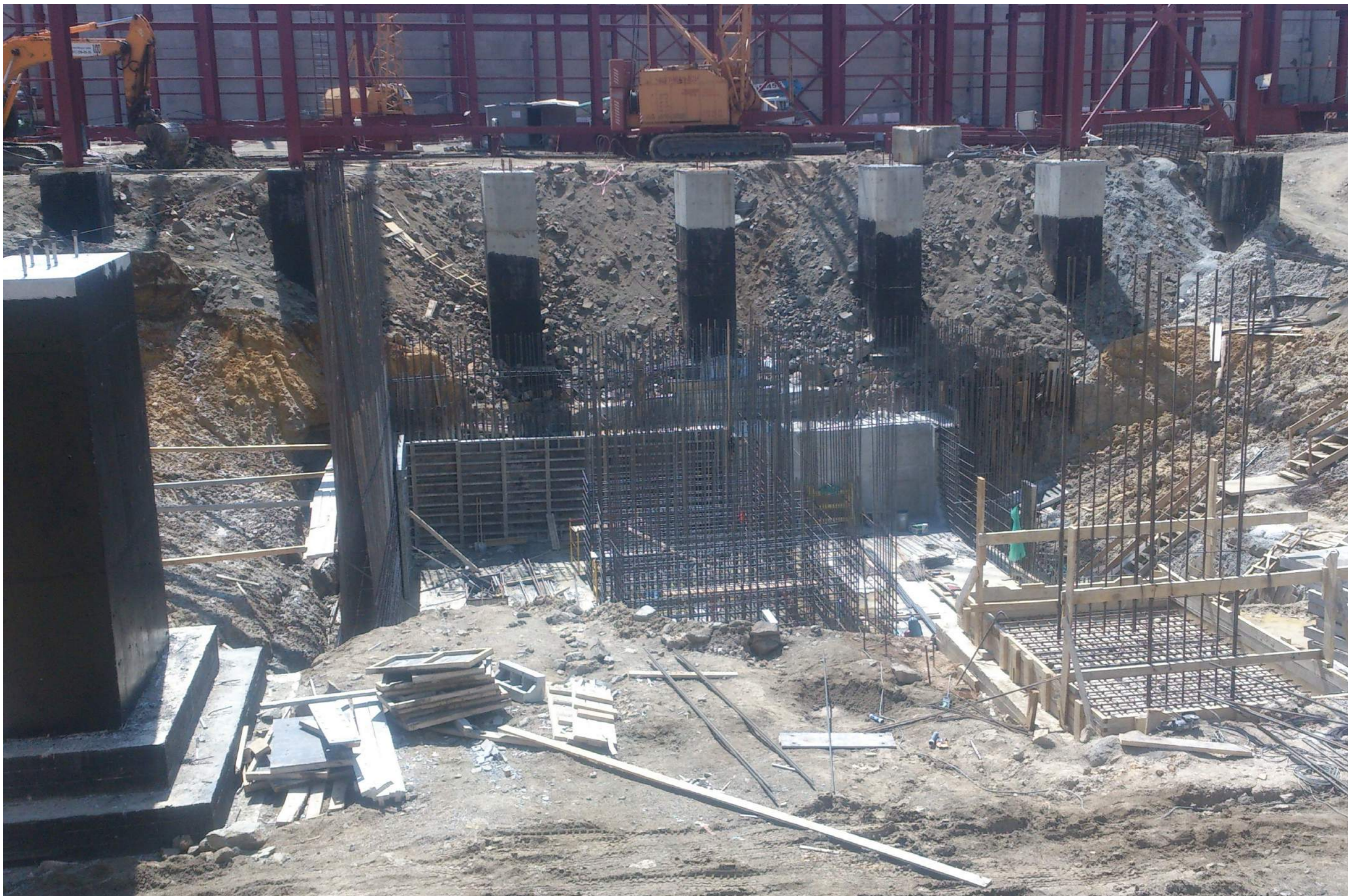
Возведение фундаментов опорных колонн и стен бассейна
