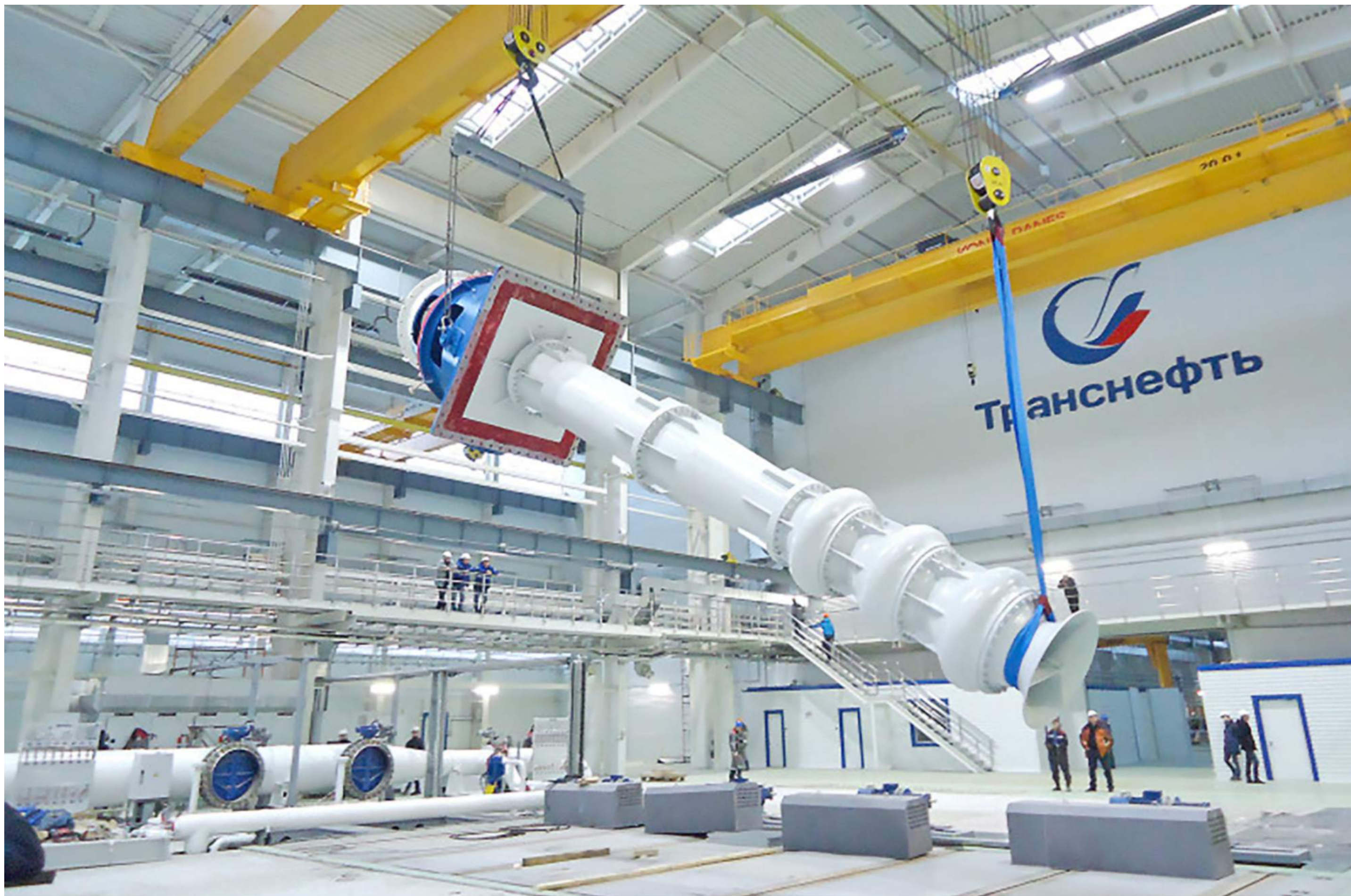
Монтаж стендовых подпорных насосов
