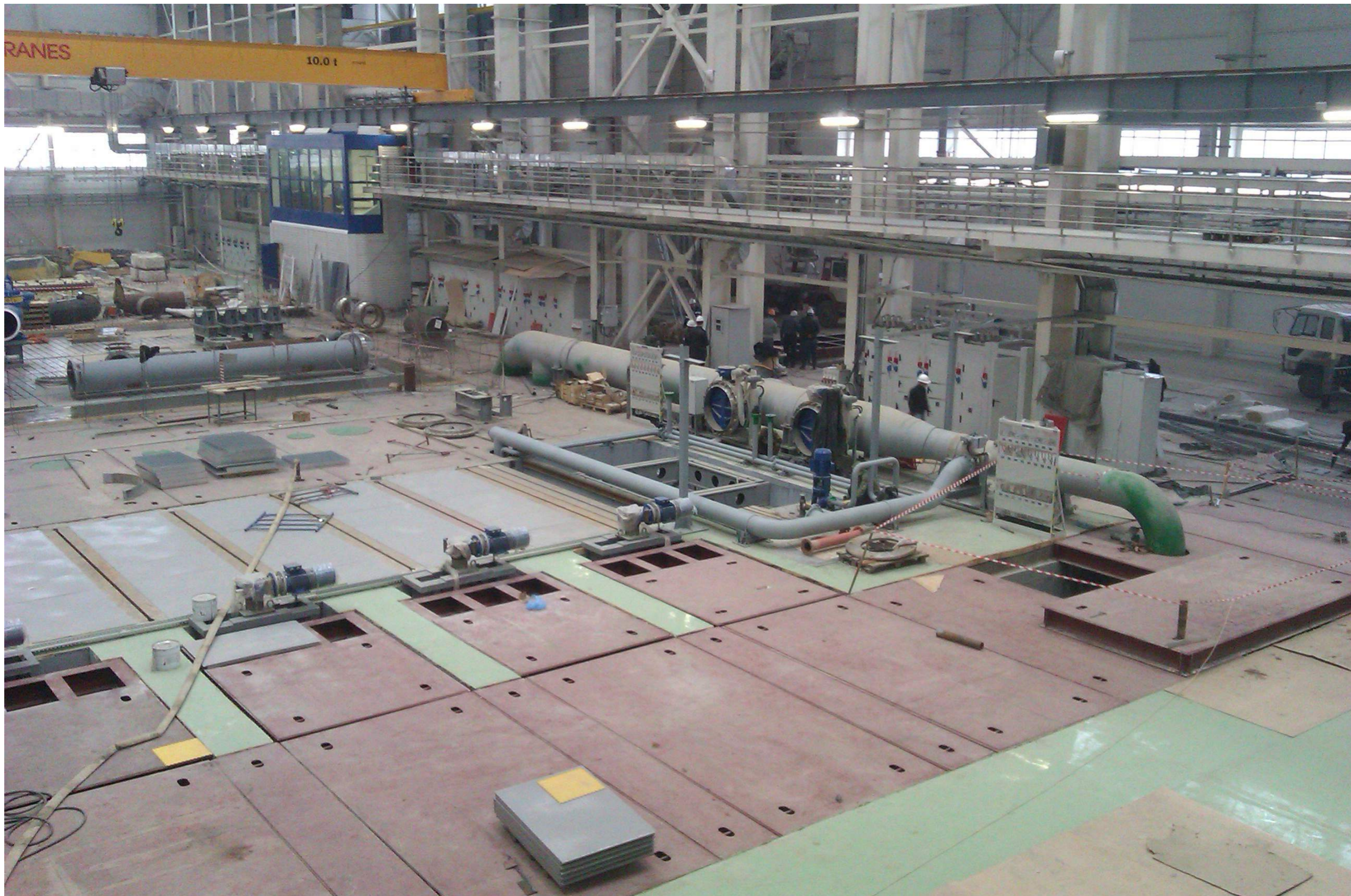
Монтаж перекрытий бассейна и электросиловых шкафов
