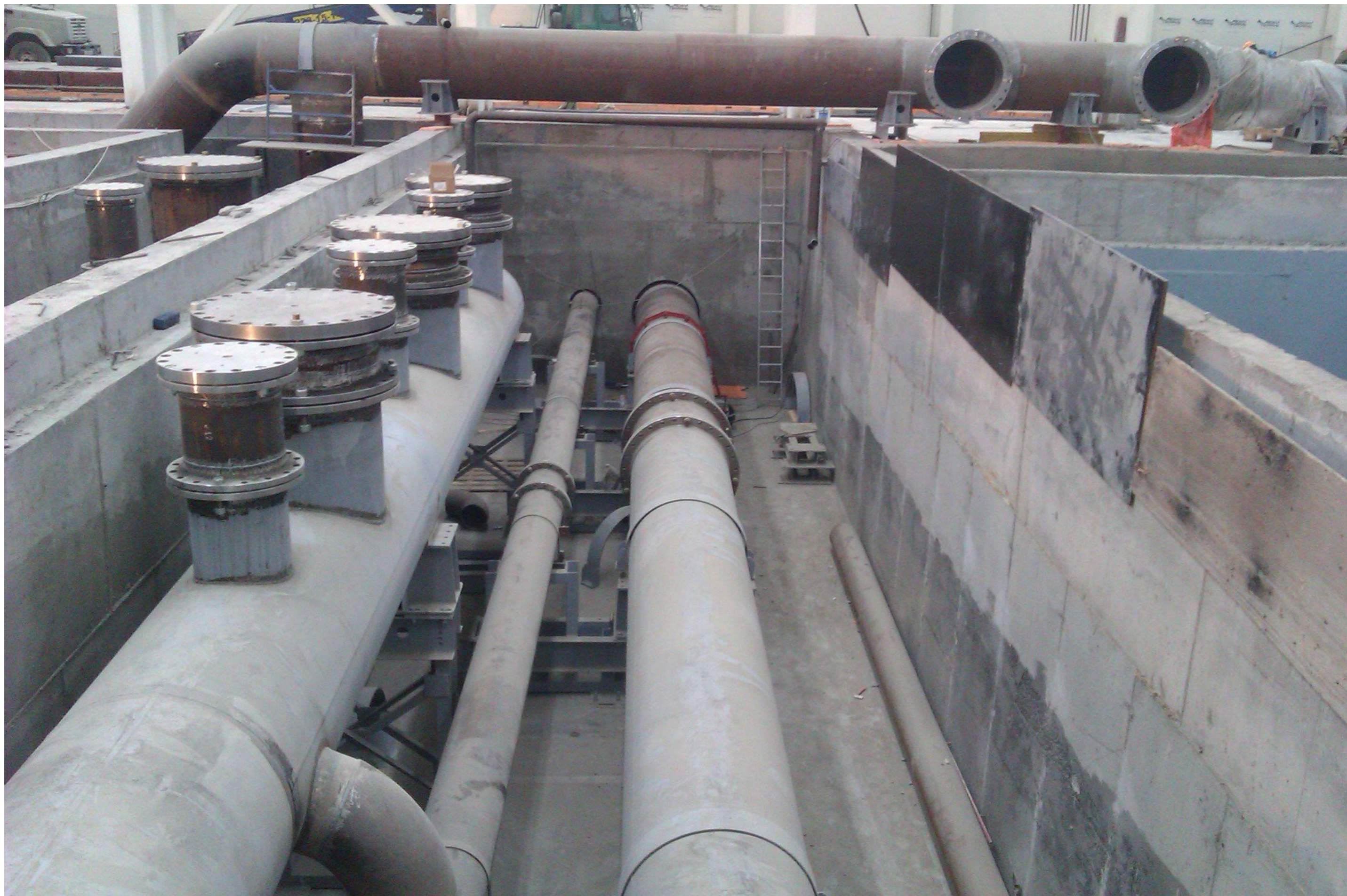
Монтаж трубопроводов для испытания вертикальных насосов
