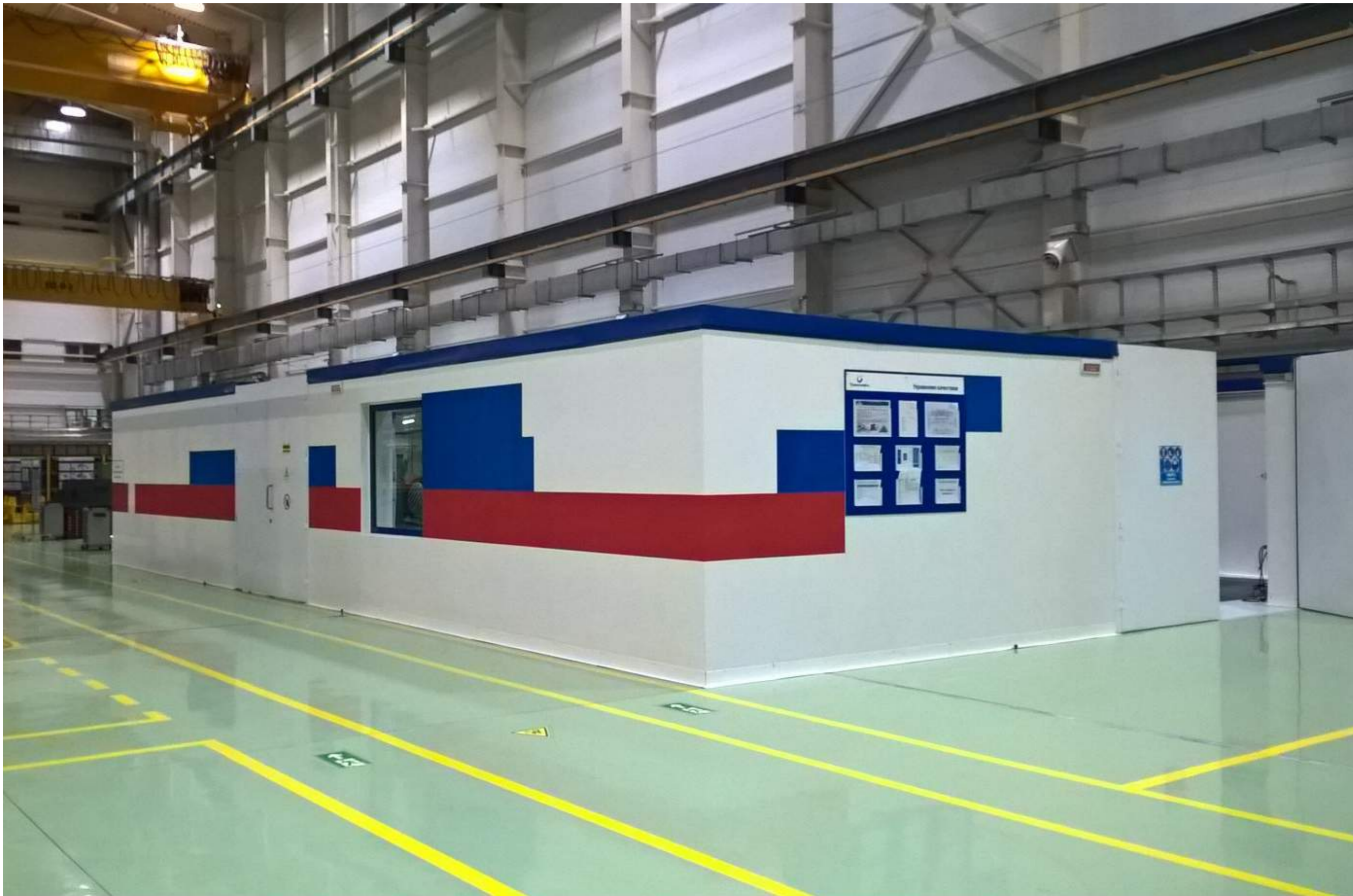
Участок гидростатических испытаний
