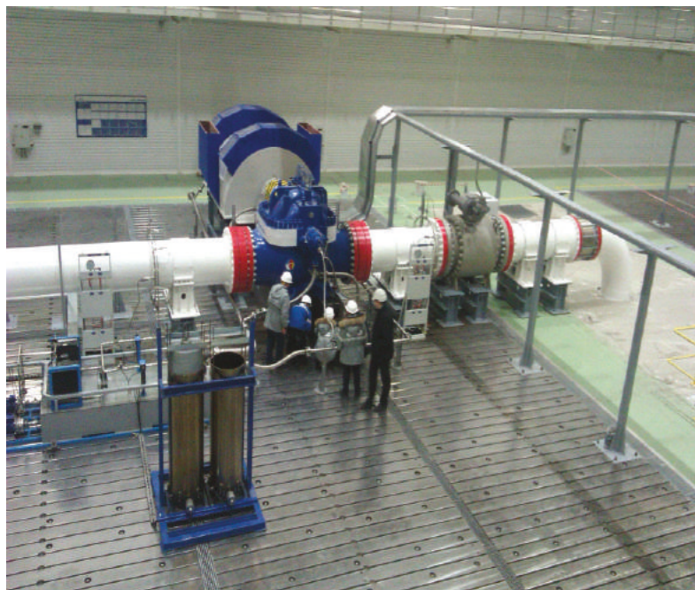
Рис. 5. Первый насос на испытаниях
