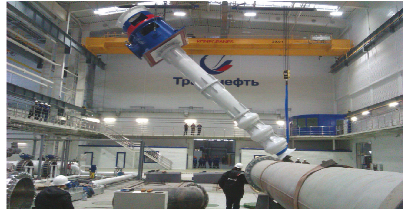
Рис. 6. Монтаж стендовых подпорных насосов
