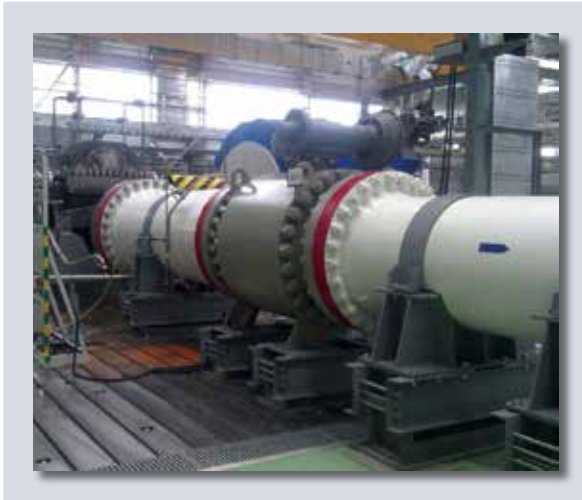
Рис. 3. Магистральный насос HM10000-210 и напорная задвижка K1.3
